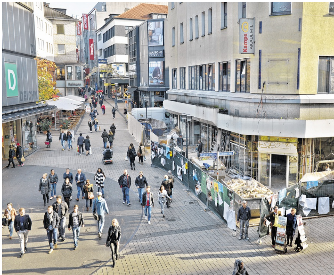
Die Ladenlokale an der Ecke Limbecker Straße/ Friedrich-Ebert-Straße werden umgebaut. Aus ehemals fünf Geschäften werden zwei. Ein Trend, der sich in der Innenstadt fortsetzen dürfte.
